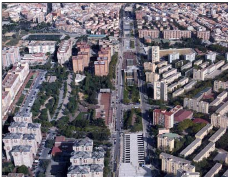
Solución infraestructural de las rondas de Barcelona y rehabilitación urbana en Nou Barris
